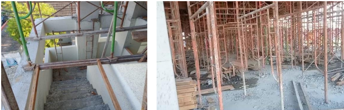
Gambar 1. Dokumentasi Kondisi Proyek
