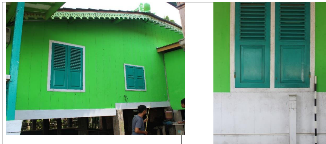
Photo 9. Dinding dan Bentuk Jendela Rumah Tradisional Mata Gual.
